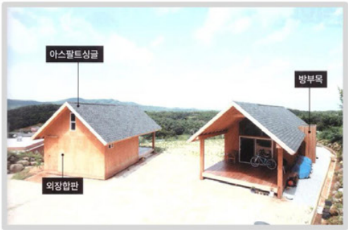
홍성주택 - 아스팔트 싱글, 외장합판 지붕은 돌회색의 아스팔트 싱글로, 외벽은 외장합판과 방부목을 그대로 노출시킨 간결한 마감으로 인상적인 집을 완성했다.
