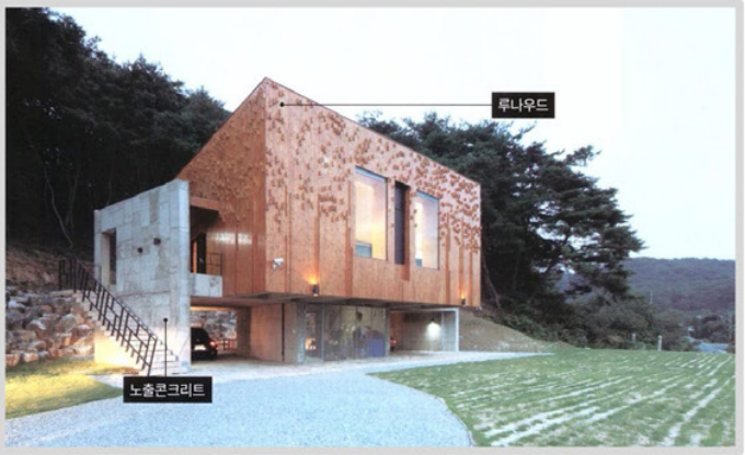
건원재 - 루나우드, 노출콘크리트 제한된 예산에 맞추기 위해 1층은 재생 거푸집을 사용하고 2층 경량목구조 부분은 집을 지으면서 베어낸 소나무를 기억하기 위해 루나우드 위에 패턴이 새겨졌다.
