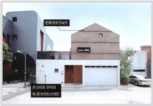
여유현 - 탄화코르크보드, 콘크리트 면처리 위 콘크리트스테인 포르투갈 유명 건축가 알바로 시자도 즐겨 사용하는 탄화코르크보드는 온도차에 따른 변형이 없고 방음 및 흡음 기능이 뛰어나다.
