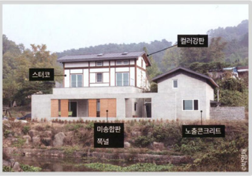
홍성 삼한주택 - 노출콘크리트, 스텐코플렉스 1층은 철근콘크리트로, 2층 벽체와 지붕은 목구조로 시공한 현대 한옥이다. 노출콘크리트 면에 미송합판 쪽널로 포인트를 주고, 2층은 스텐코플렉스로 마감했다.
