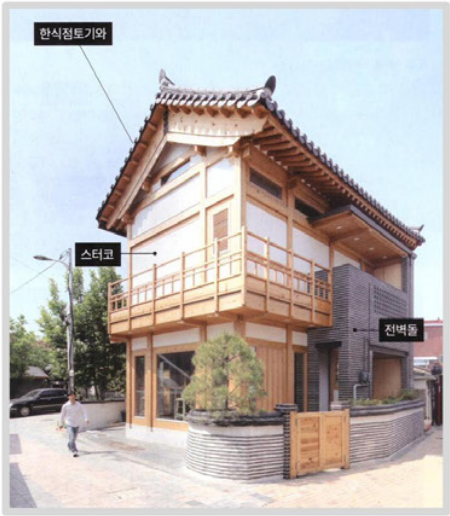
수원 호원재 - 한식점토기와, 스텐코, 전벽돌 노출된 목구조를 보호하는 더블스킨 개념으로 전벽돌을 쌓고 시멘트보드 위 백색 스텐코로 마감했다. 스텐코리스 물품기를 도입하고 지붕은 못 구멍과 접합부 요철을 추가 주문한 한식점토기와로 마감했다.
