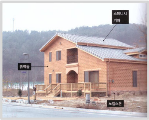
세종시 주택 - 흙벽돌, 블록 항토를 고유압으로 찍어내 자연양생한 흙벽돌을 골조로 삼고 스페니시 기와는 지역 조례에 맞춰 짙은 회색으로 칠했다.
