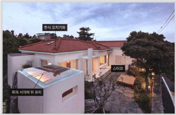
제주 위미주택 - 한식 오지기와, 스텐코 기존 주택을 리모델링한 제주의 게스트하우스, 골조를 최대한 그대로 두고 입면은 단일 색상의 스텐코로 마감, 제주의 전통 돌담과 현무암이 더욱 돋보이게 했다.
