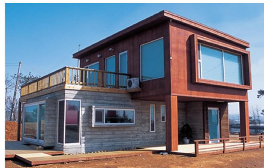
1층은 노출콘크리트로, 2층은 버티컬 목재 사이딩으로 마감한 철근콘크리트 주택
